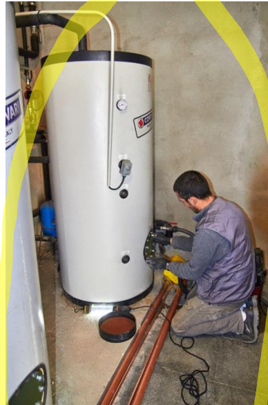
APERTURA DE LOS ACUMULADORES PARA SU LIMPIEZA INTERIOR
