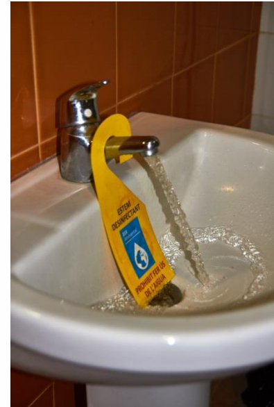
LIMPIEZA Y DESINFECCIÓN DE PUNTOS TERMINALES
